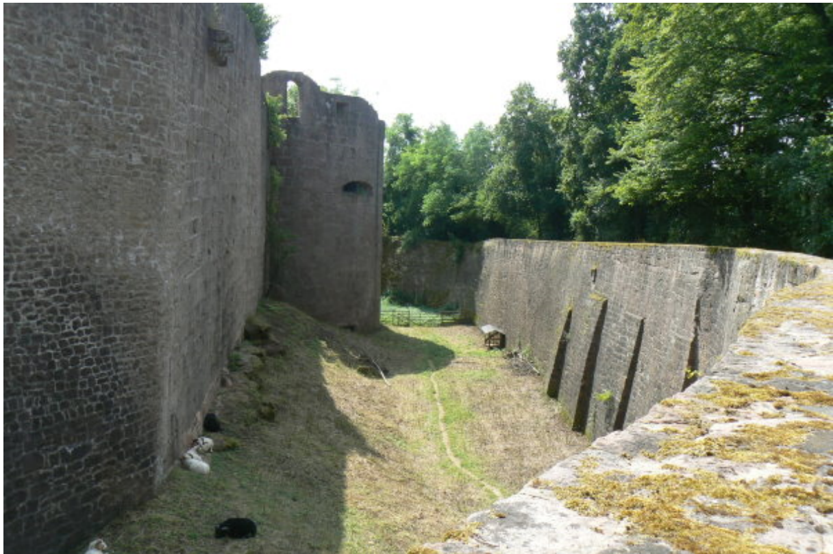
Trockengraben mit Südturm
