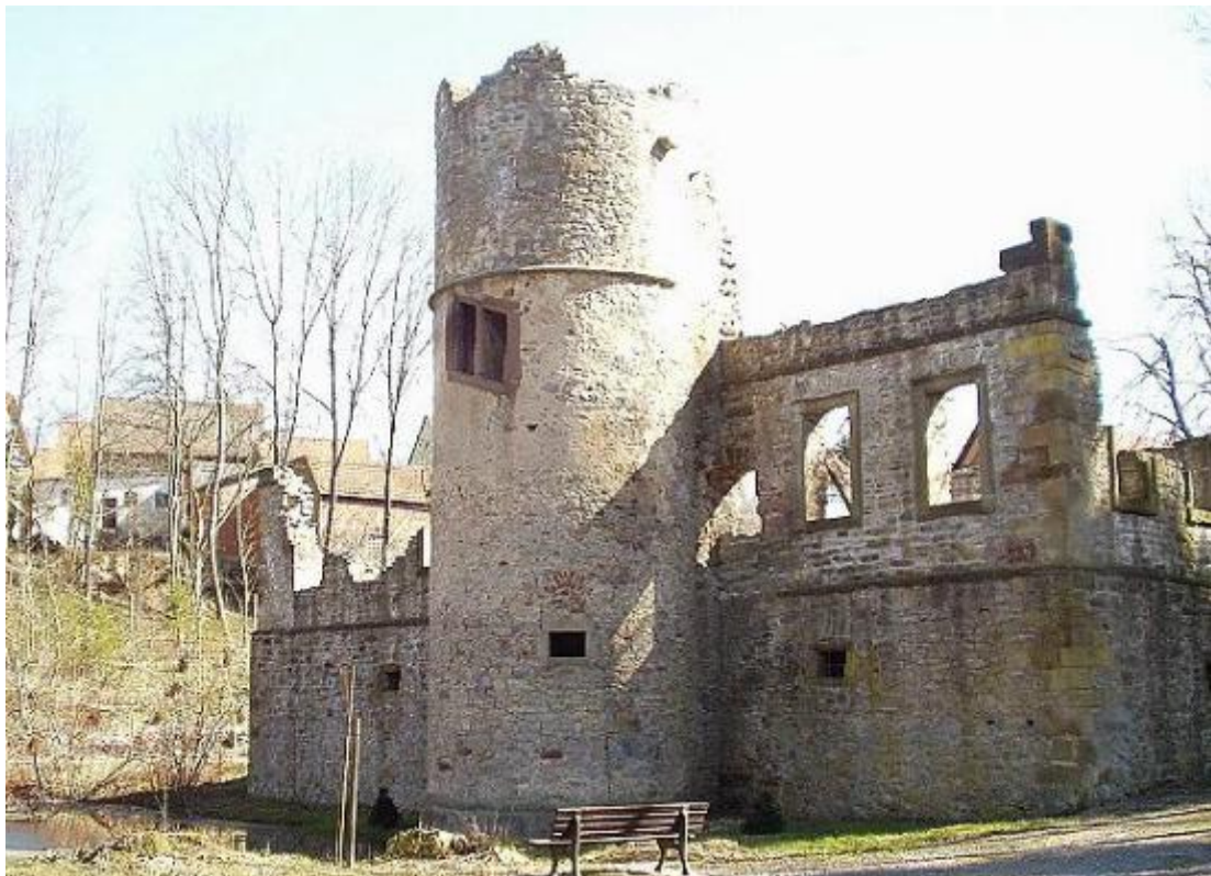
Südseite mit Treppenturm
