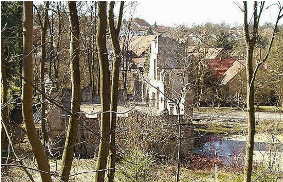
Ruine von der östlichen Hangseite gesehen
