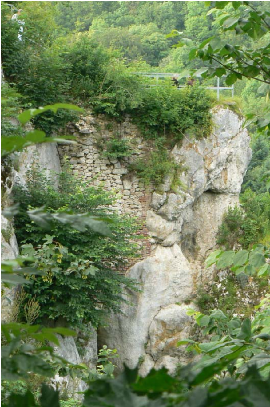
Mauerrest am Burgfelsens über dem ehemaligen Brunnenschacht unten im Eselsburger Tal
