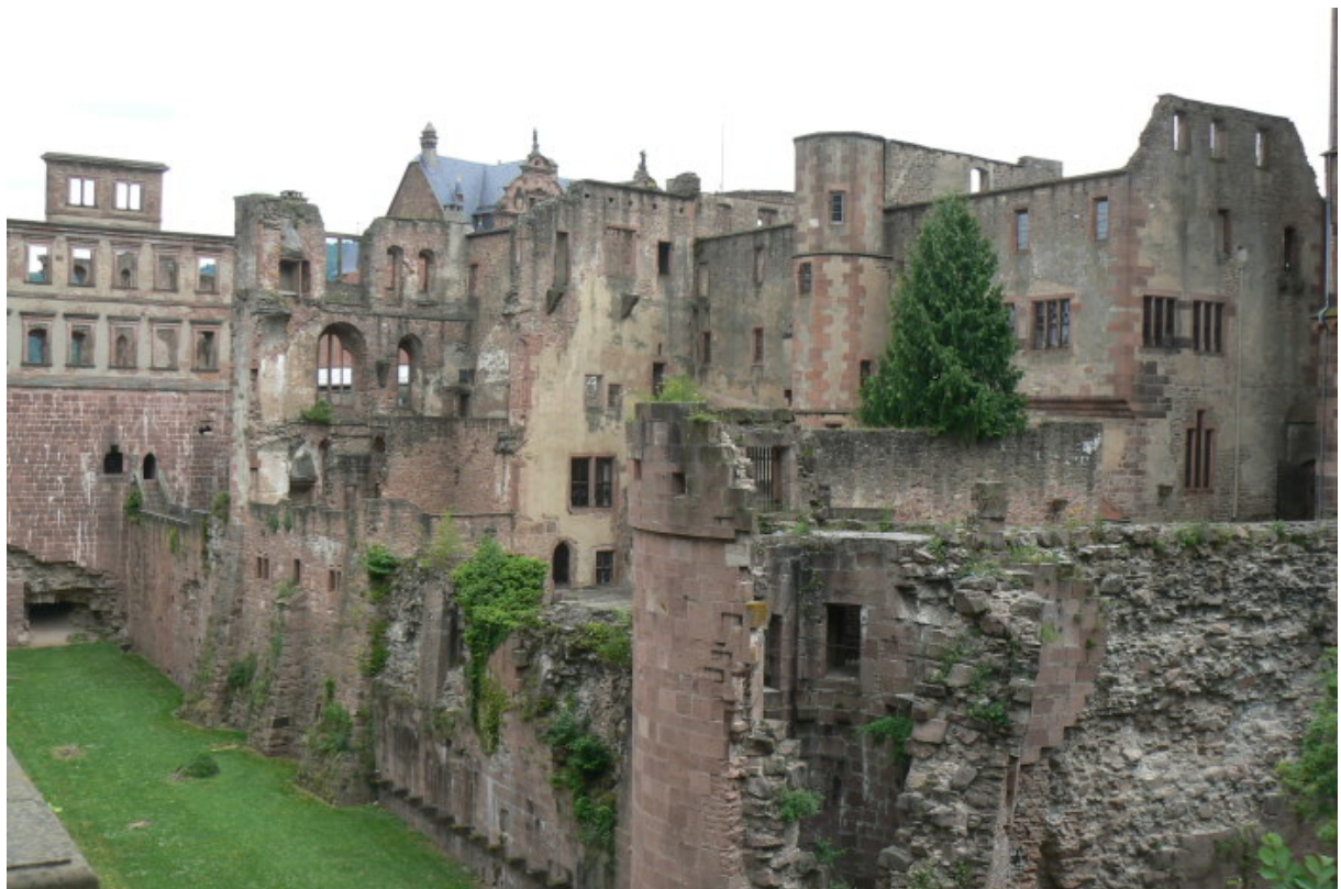
Westseite mit Bibliotheksbau
