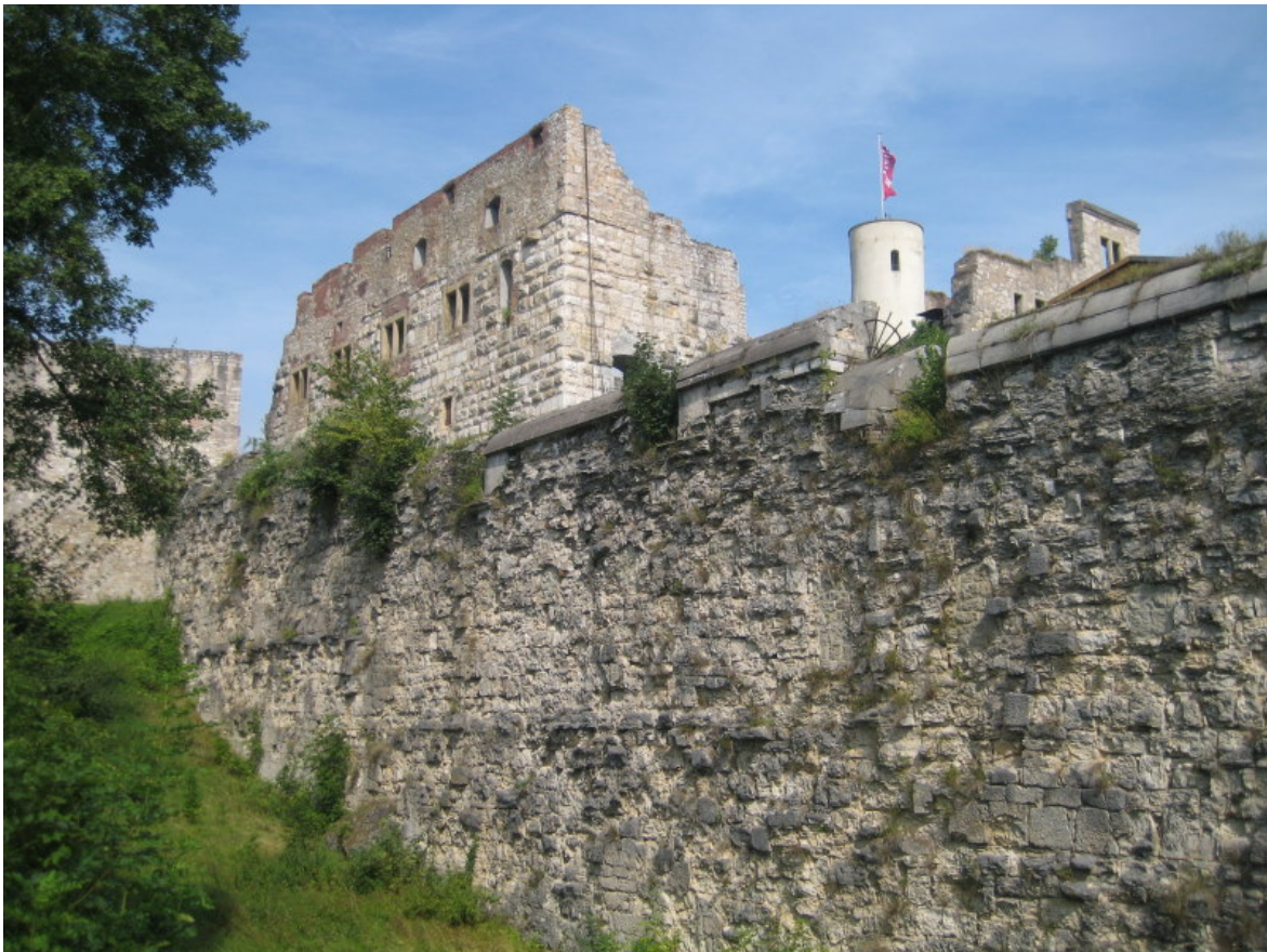
Staufische Kernburg mit südlicher Zwingermauer
