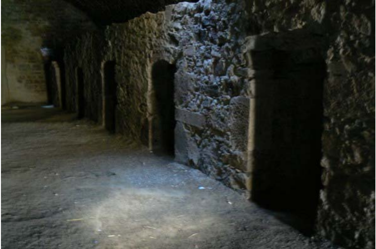
Zellen im Kellergewölbe
