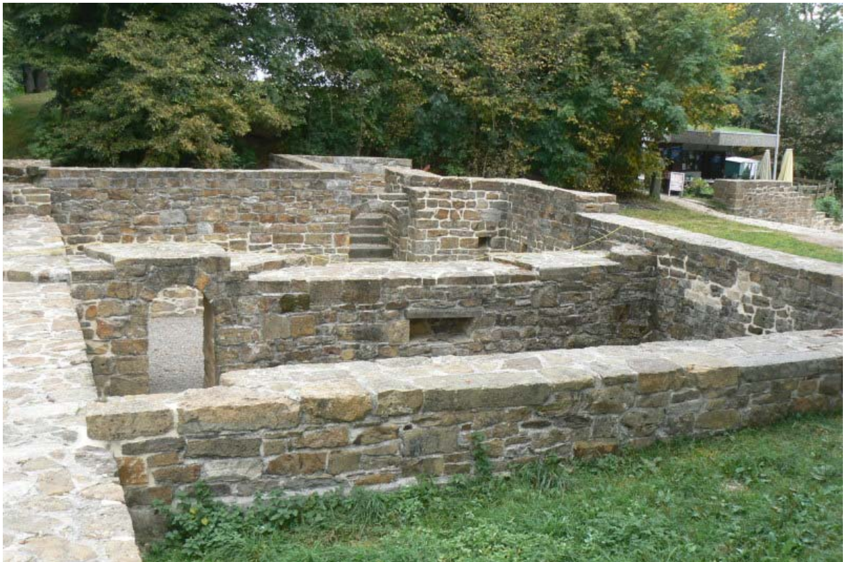
Gebäudereste auf der Nordseite
