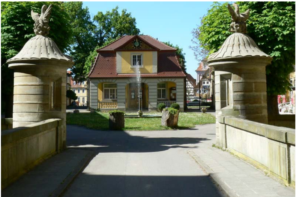
Wachthaus mit Brücke und Schildhäuschen
