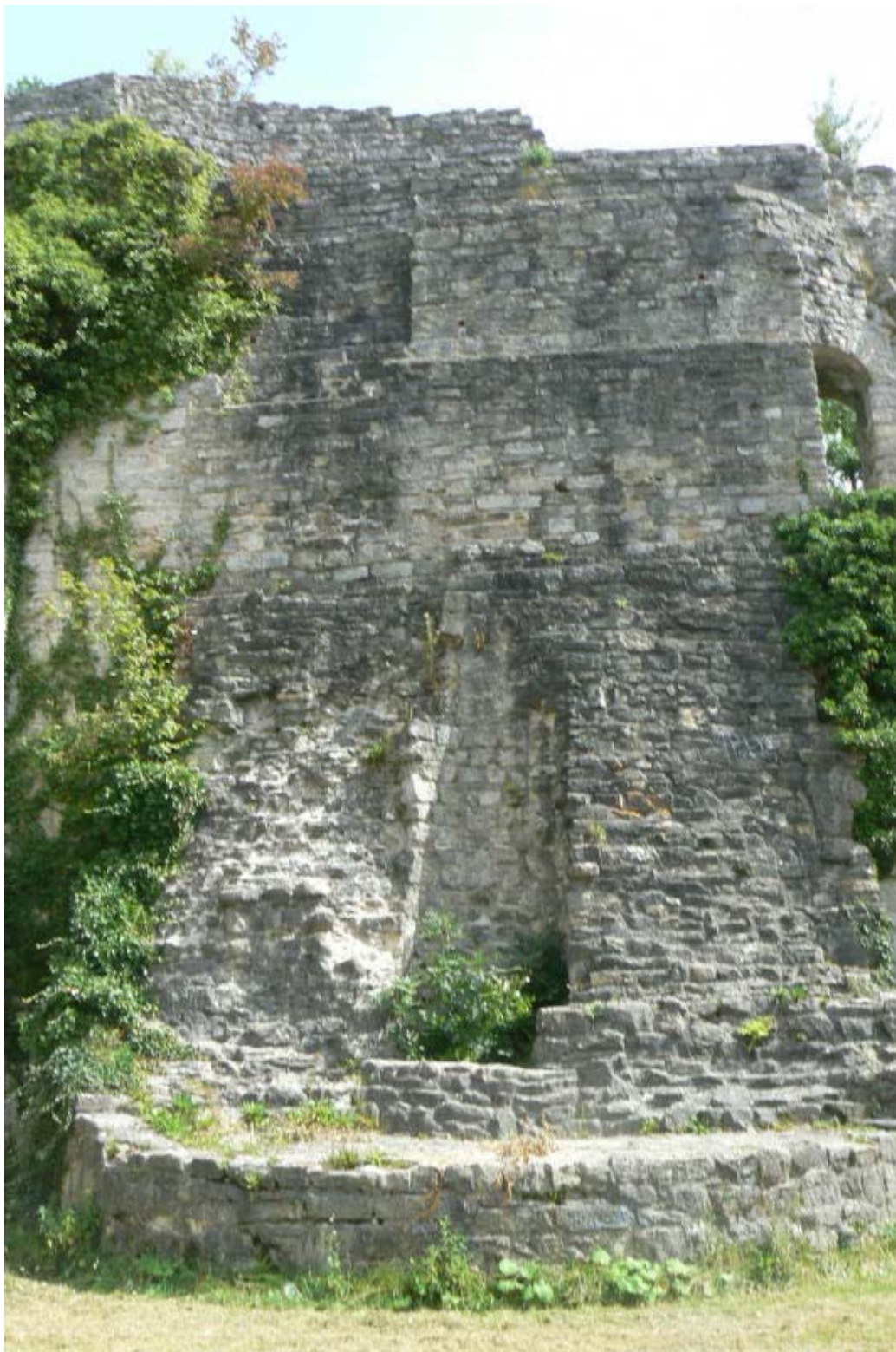
Blick auf den Bergfriedstumpf mit seinen dicken Mauern
