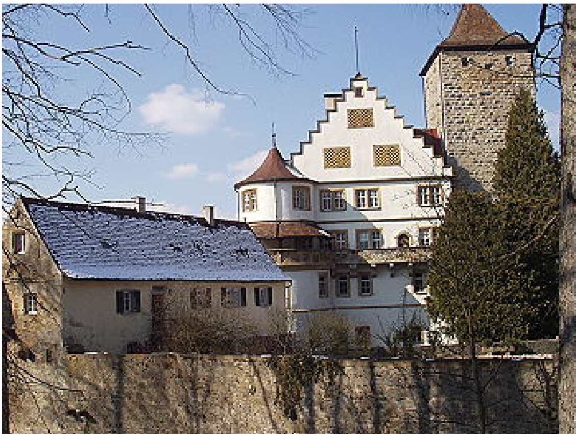
Blick vom Ortsrand über den ersten Graben
