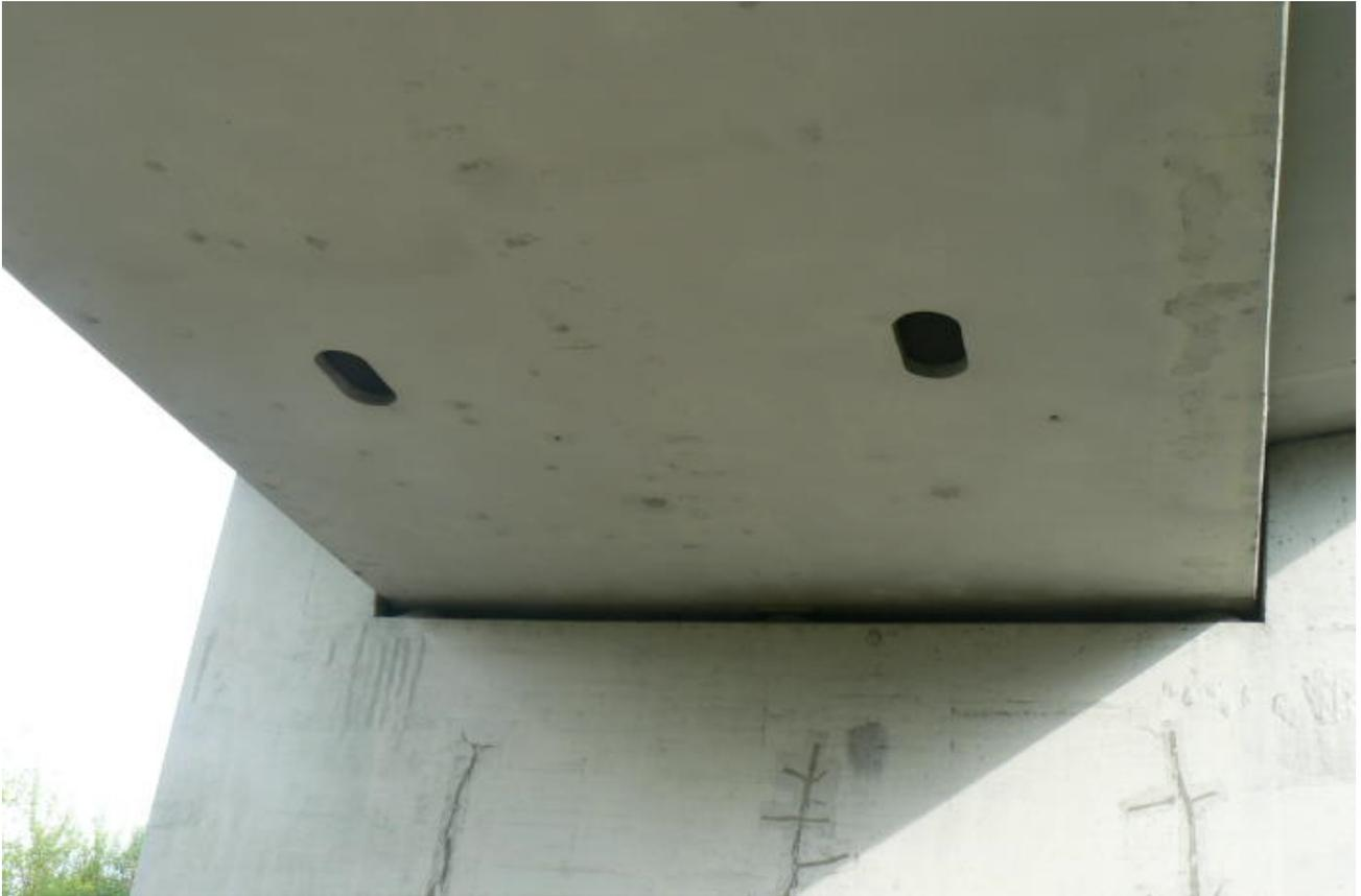
*Wartungsöffnungen zum Hochziehen von Sprengladungen in das Brückeninnere an einer süddeutschen Autobahn*
