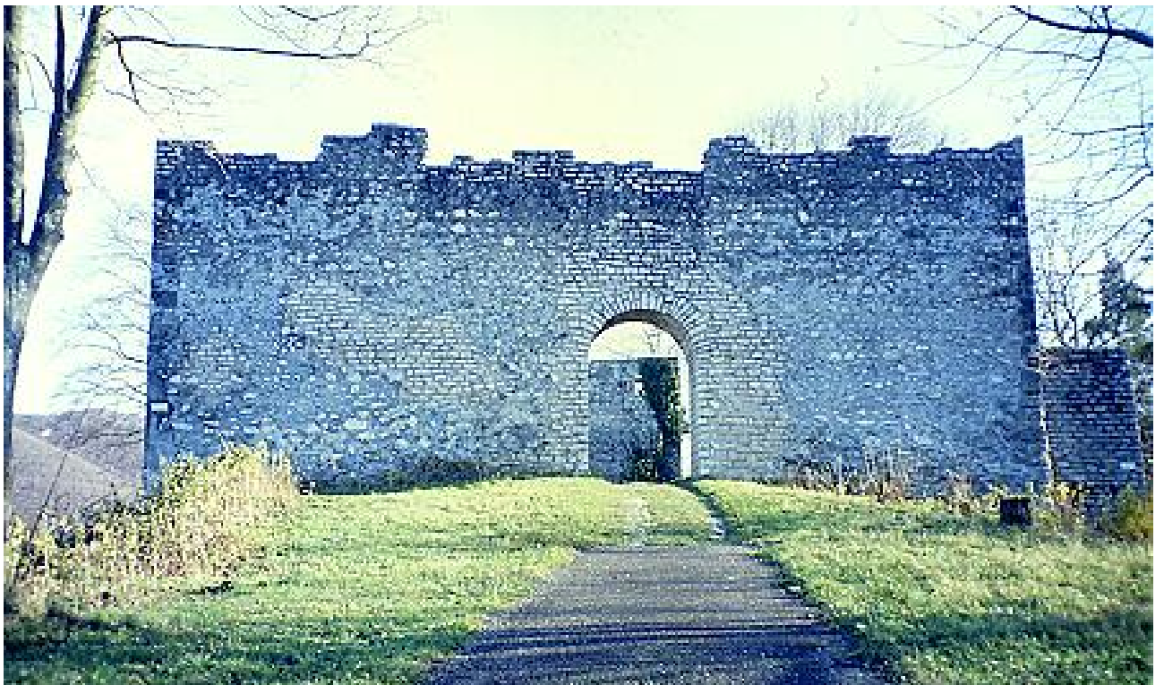
Schildmauer mit neuem Eingangportal
