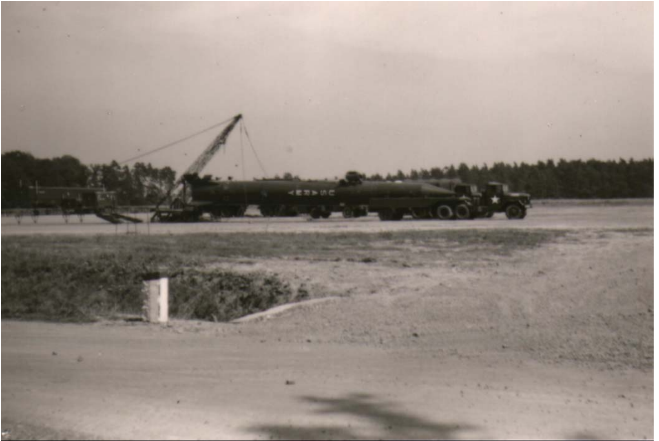
Aufbau der Rakete /Installation of the missile © by Wolf
