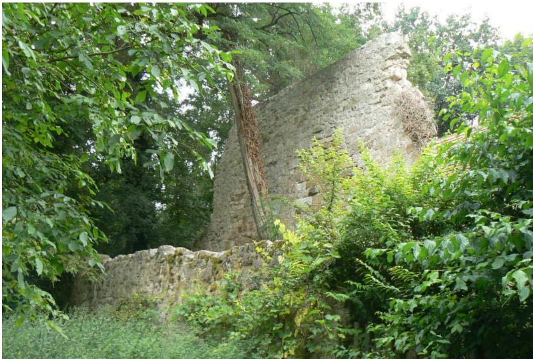
Südliche Mantel- und Zwingermauer der Burg Wart
