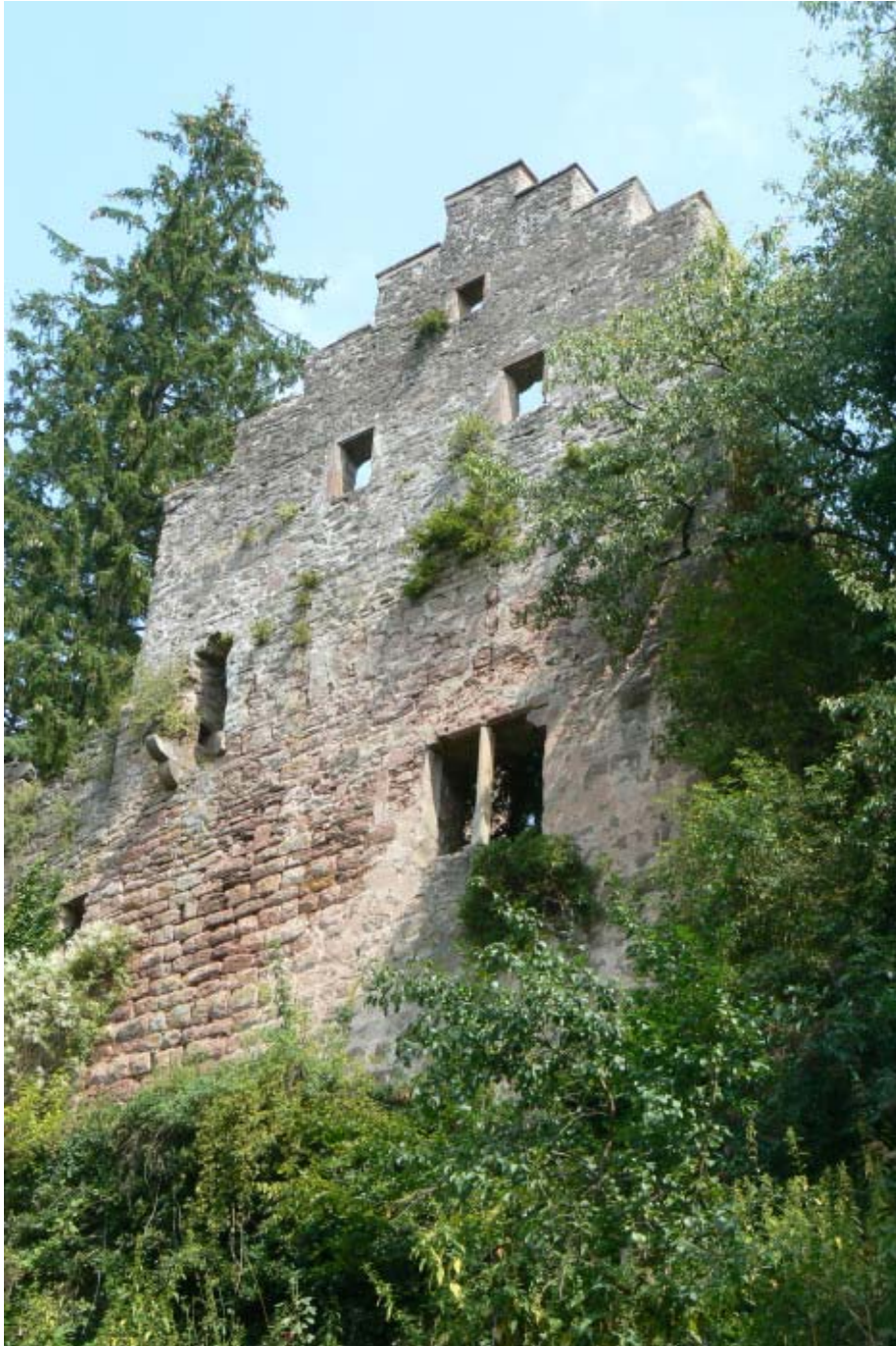
Westlicher Treppengiebel im „Alten Bau“
