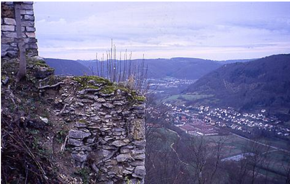
Außenmauer der östlichen Burg mit Blick ins Filstal
