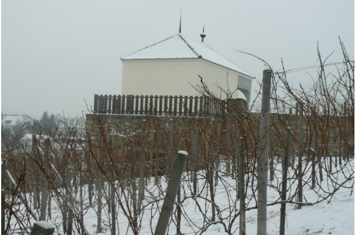
Turmfundament mit Eingang Gewölbekeller (vorne) von Westen
