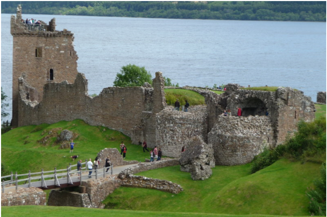
Doppelturmtorhaus und Brücke auf der Westseite
