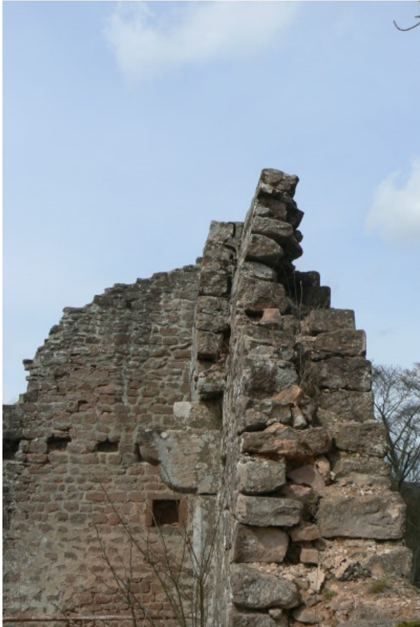
Einsturzgefährdete Ostmauer im Südgebäude
