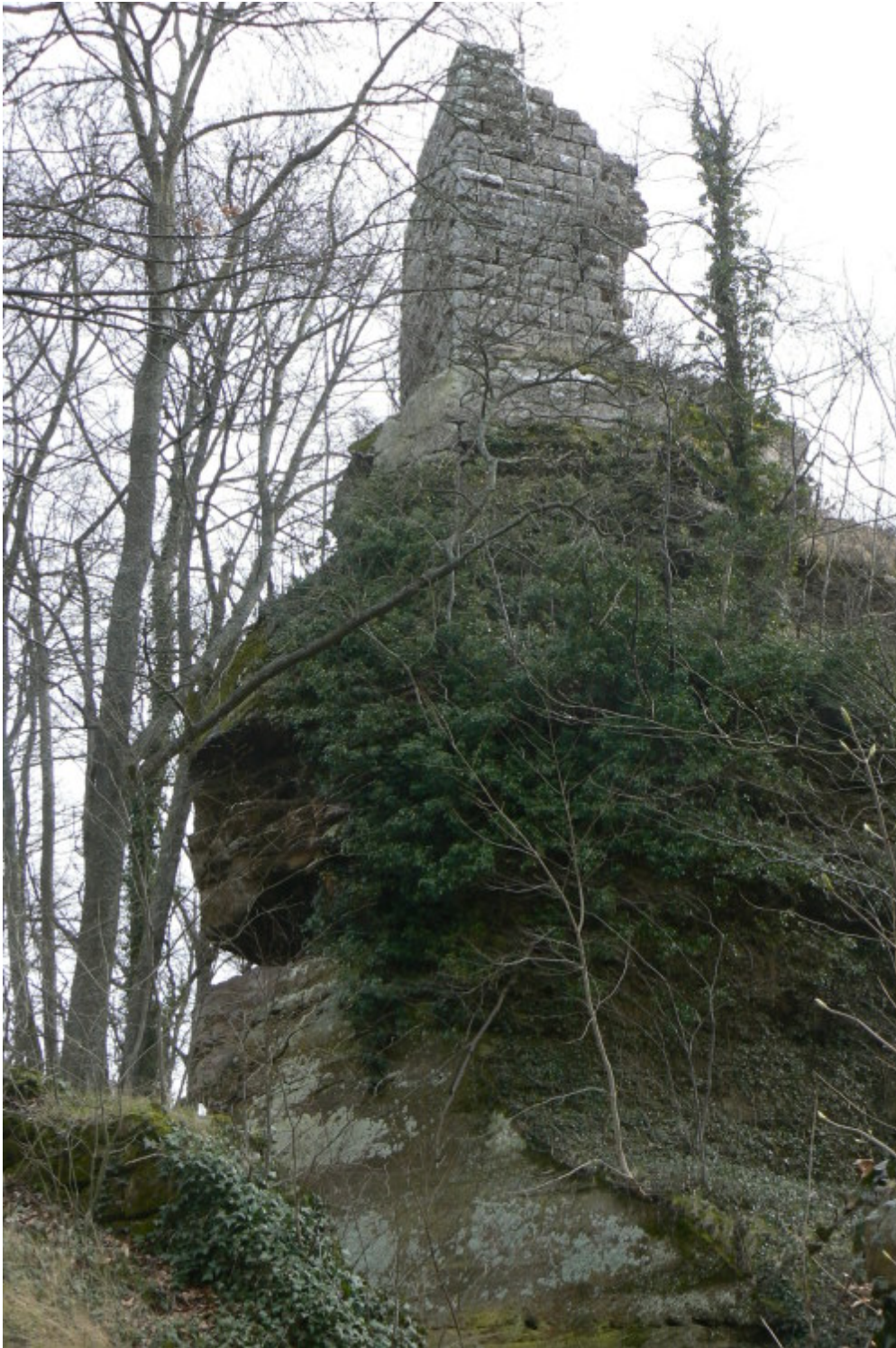
Keilförmige Mauerverstärkung des Nordgebäudes
