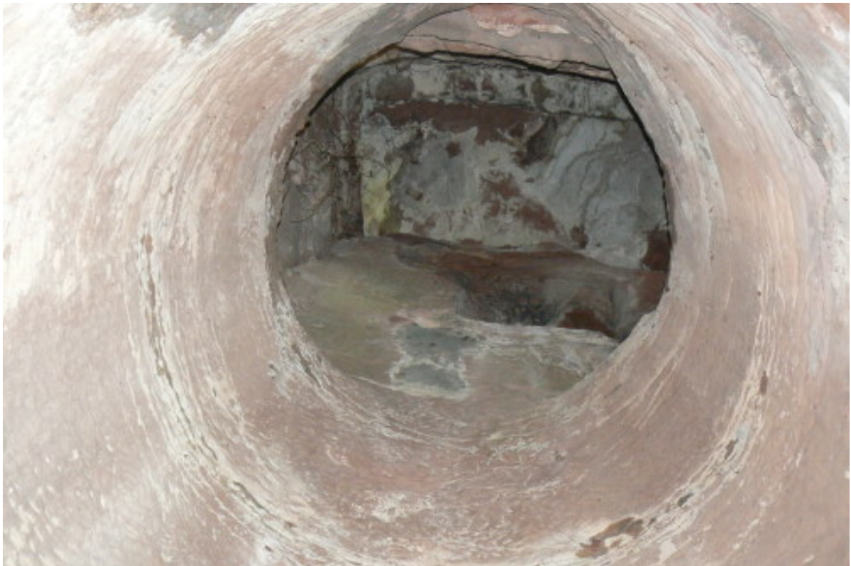
Brunnenturm von innen nach oben gesehen
