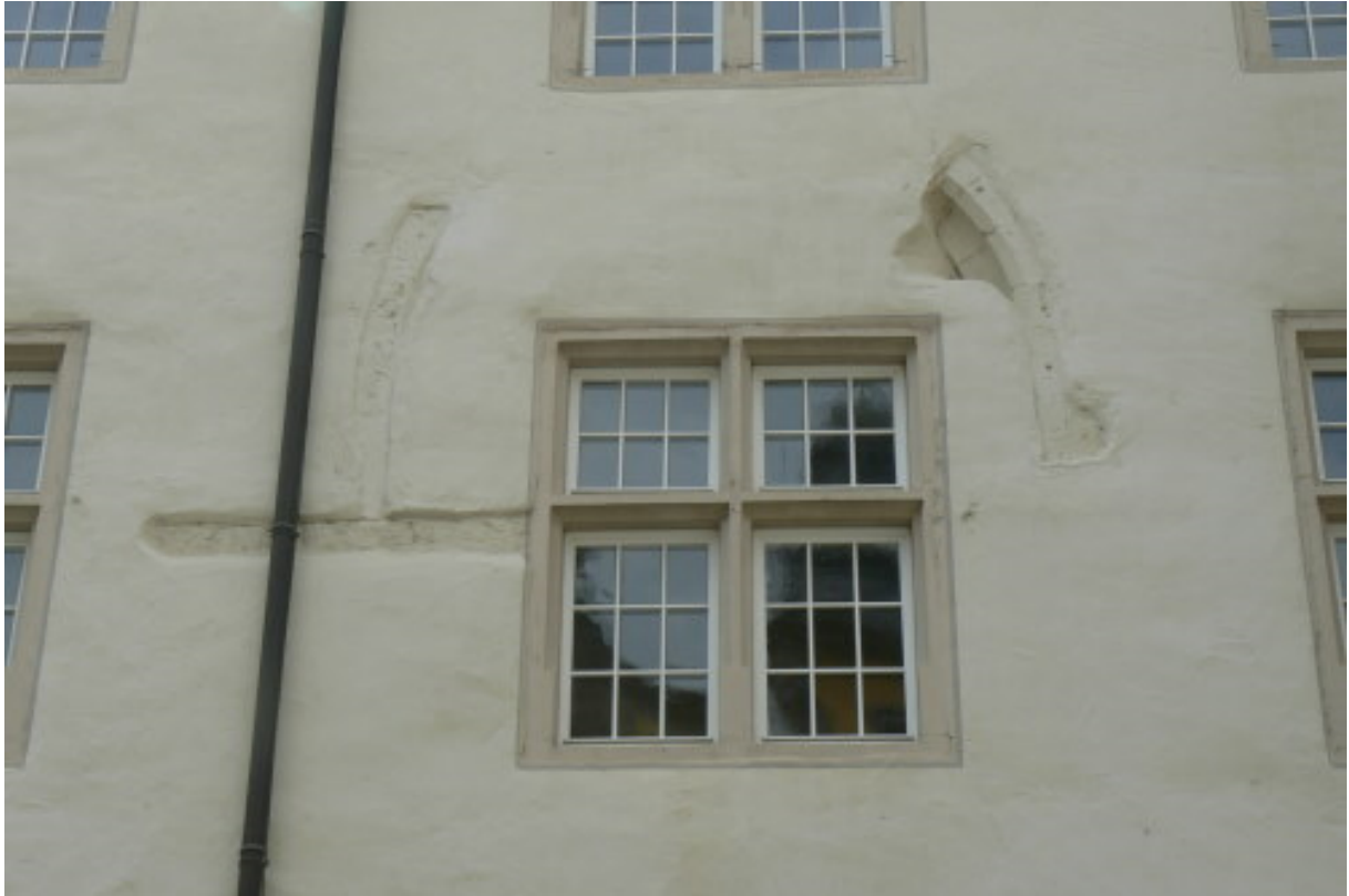
Fenstergewände im Innenhof
