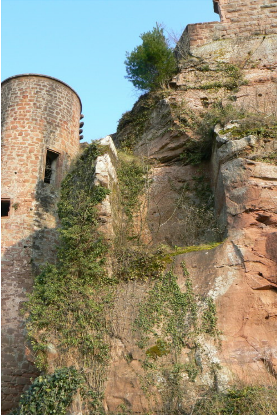
Rest der Zisterne in der Oberburg
