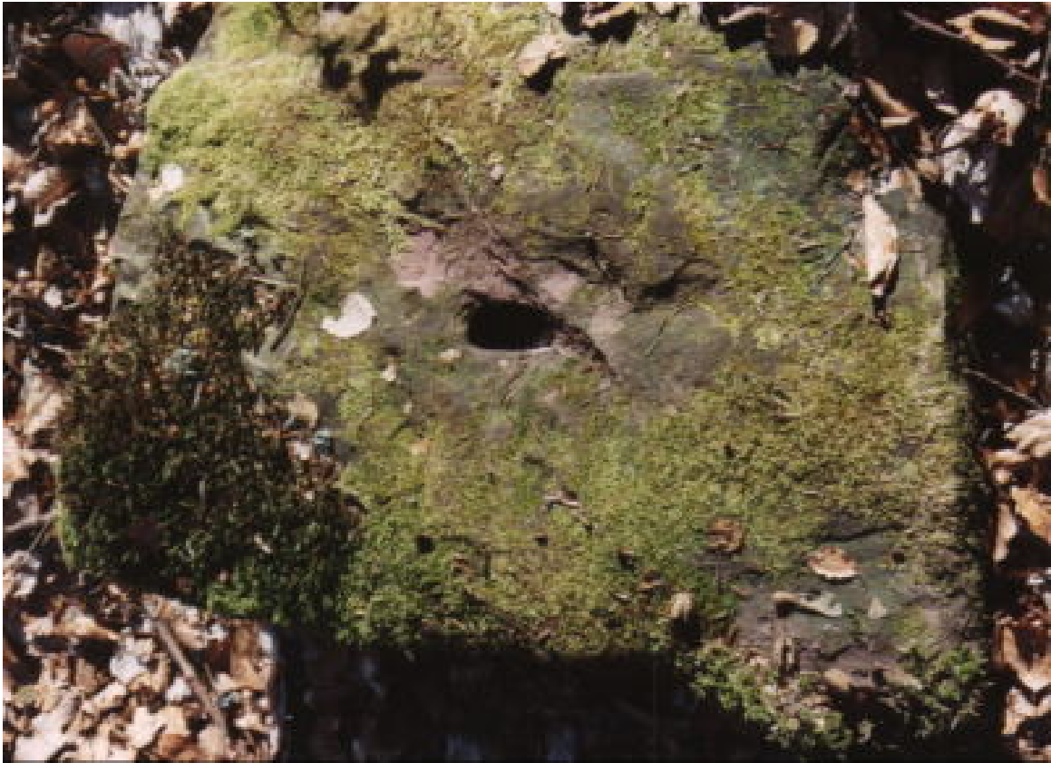
Buckelquader von oben mit Wolfsloch
