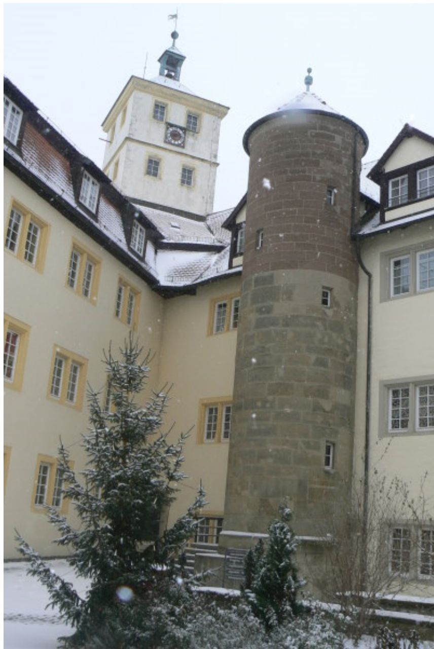
Stadtturm, Treppenturm und Gebäude im Innenhof
