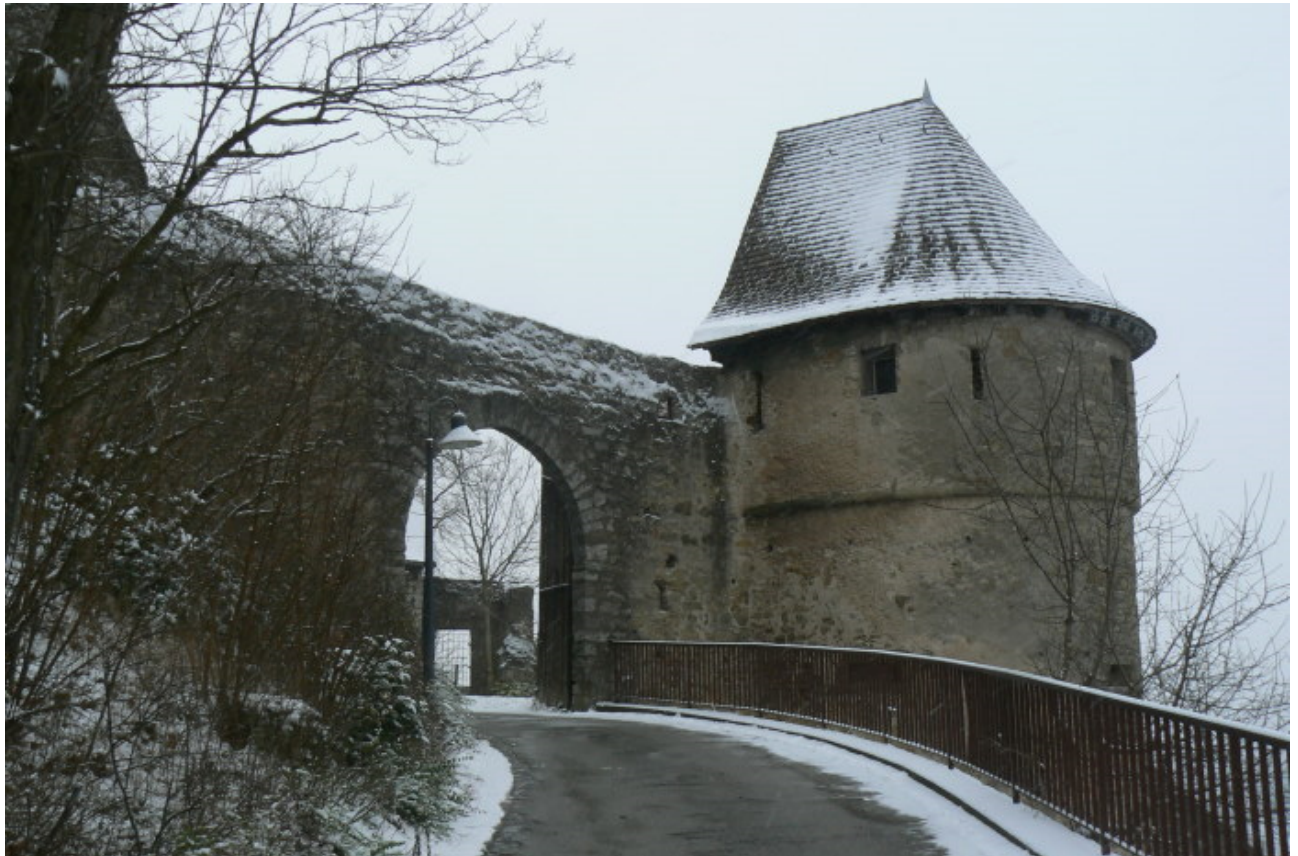
Westzugang mit Halbschalenturm
