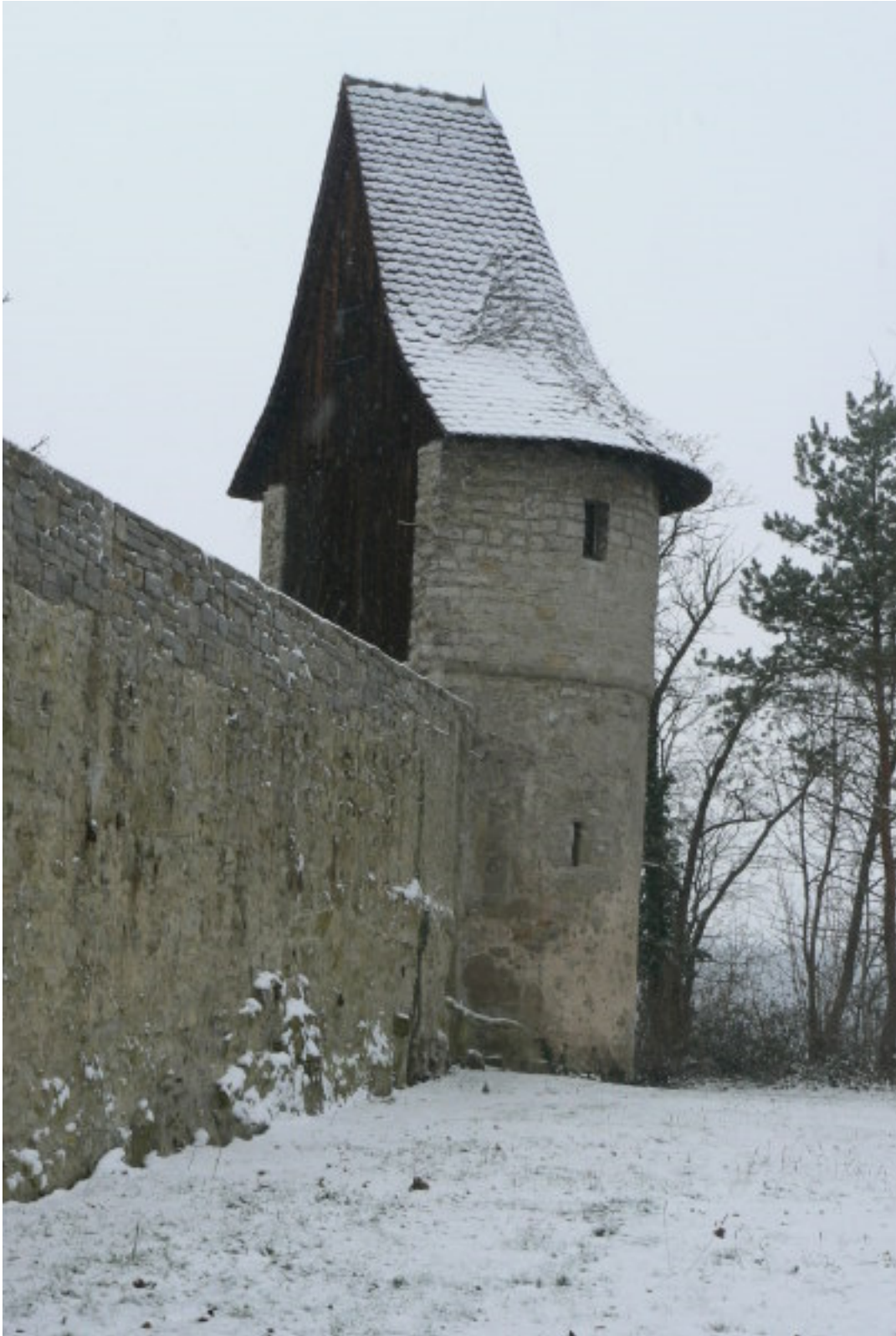
Nördlicher Halbschalenturm in der Mauer des Außenzwingers
