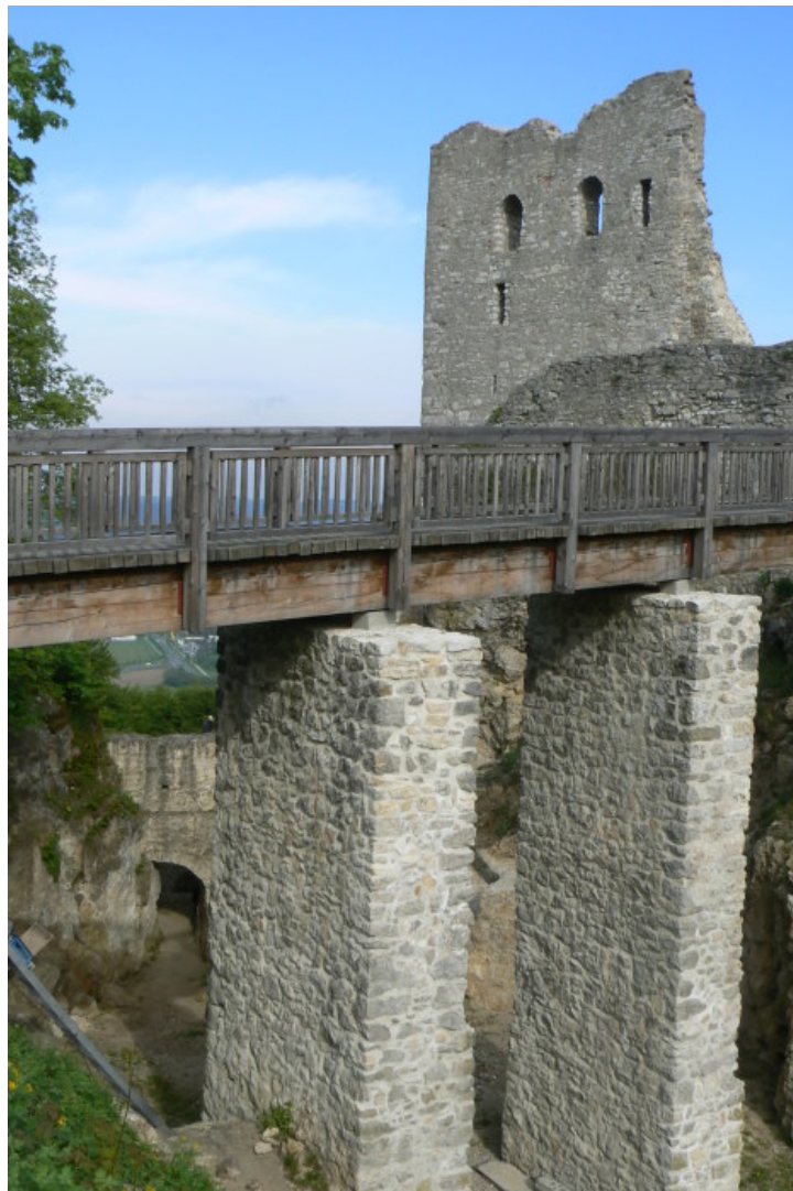
Halsgraben mit Brücke
