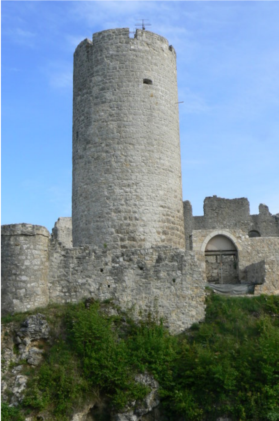
Bergfried mit Torrondell (links) und ehemaliger Kernburgeingang (rechts)
