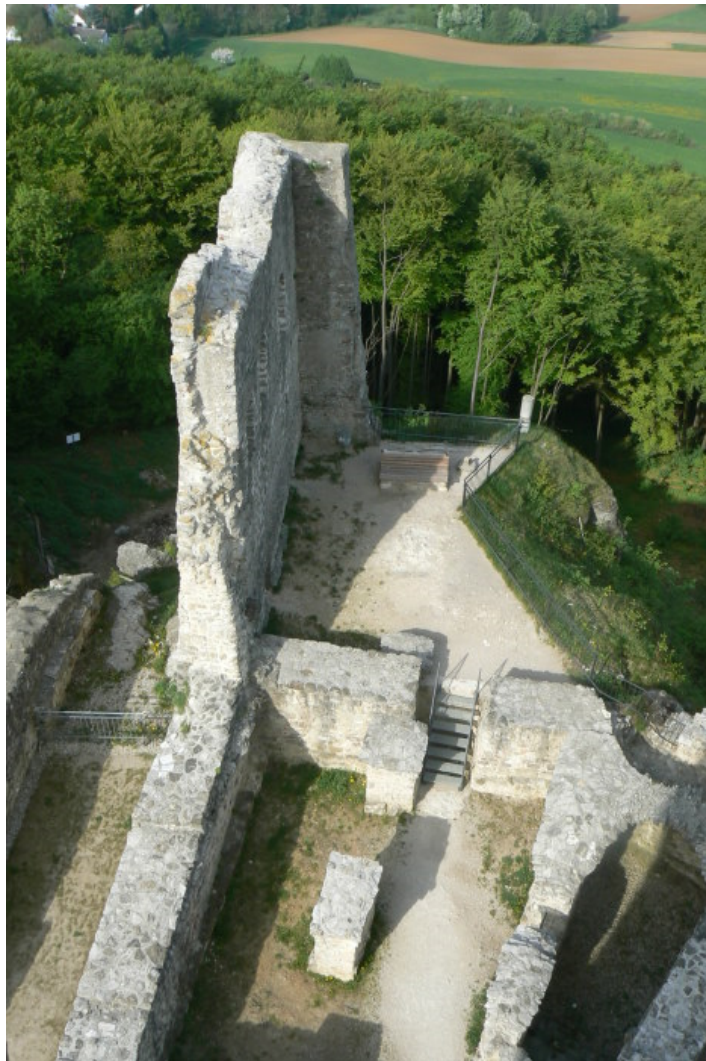
Turmartiges Gebäude an der Südwestspitze (links Zwinger zum Halsgraben)
