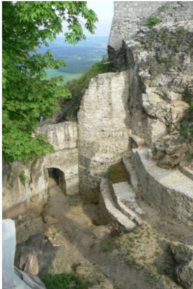
Spermauer im Halsgraben (Südwestecke)
